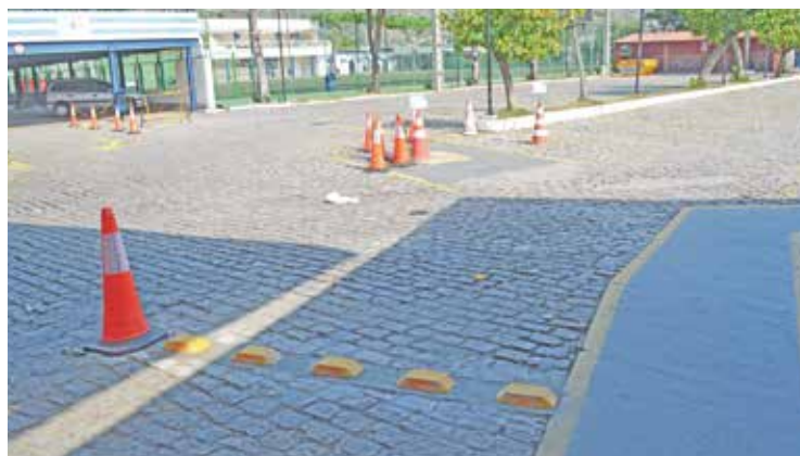
Colocação de tachões para redução de velocidade no estacionamento
