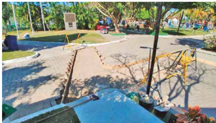
Pista de acesso a cadeirantes sendo construída por todo o clube
