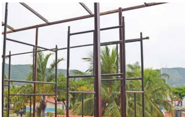
Reforma na estrutura e no toldo que cobrem o varandão do salão social
